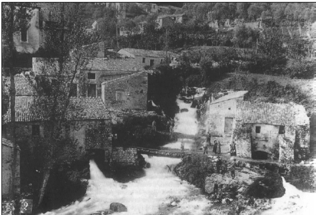
Sanità spring before tapping works (Courtesy of Acquedotto Pugliese)
