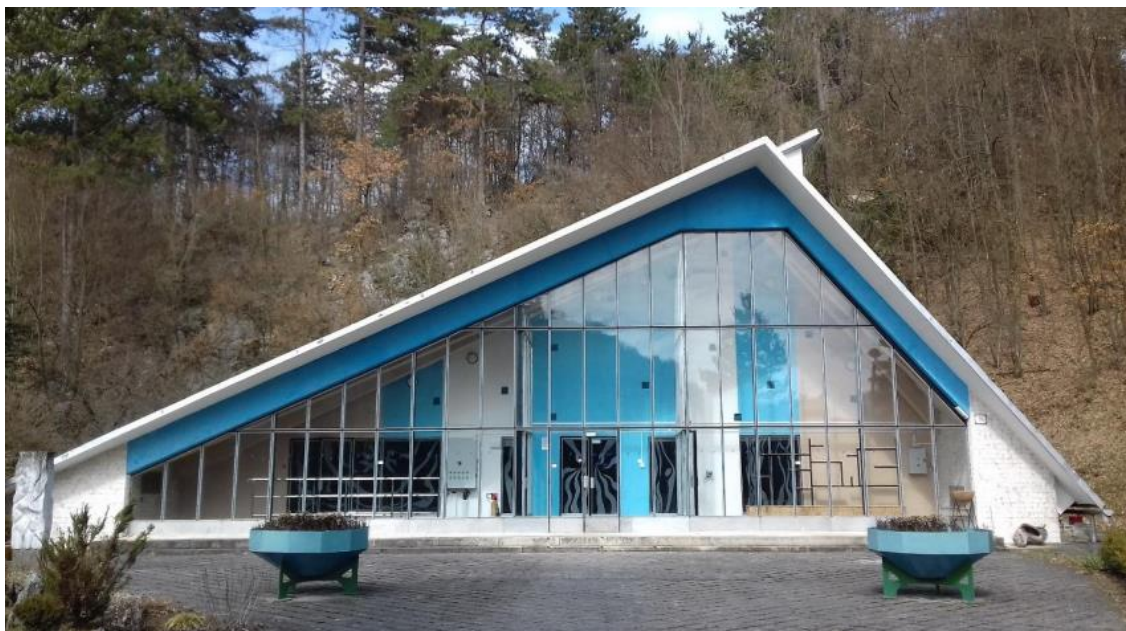
General view of the Vrchovište spring waterworks intake facility in Slatinka nad Bebravou. Photo: archive of Západoslovenská vodárenská spoločnosť, a.s. waterworks.
